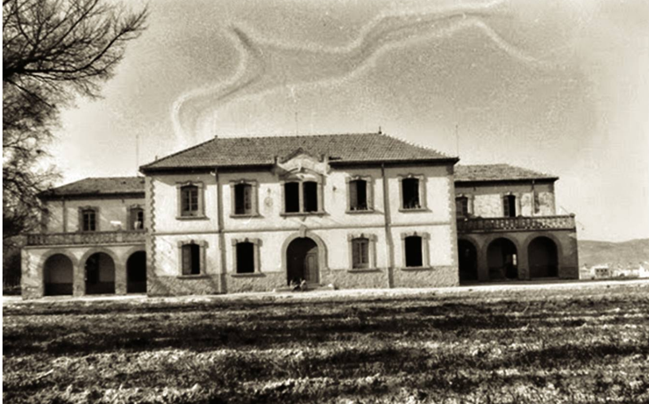
Vista del Orfanato de Caudete del que se cumple el centenario del inicio de su construcción.
